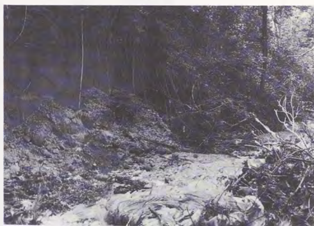
Fig. 11 - Valle Tiglio. Parziale cedimento di sponda in alluvioni antiche per sottoescavazione di materiali sciolti, essenzialmente sabbiosi. Alveo ingombro di detriti, tra cui fogli di materiale plastico di uso agricolo. L'asta appoggiata alla sponda misura 2 m.
