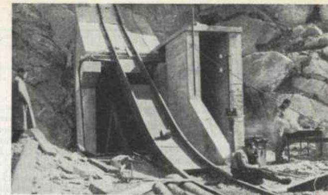
Fig. 12. - Dispositivo per il passaggio del carrello dal primo al secondo tronco del piano inclinato.
