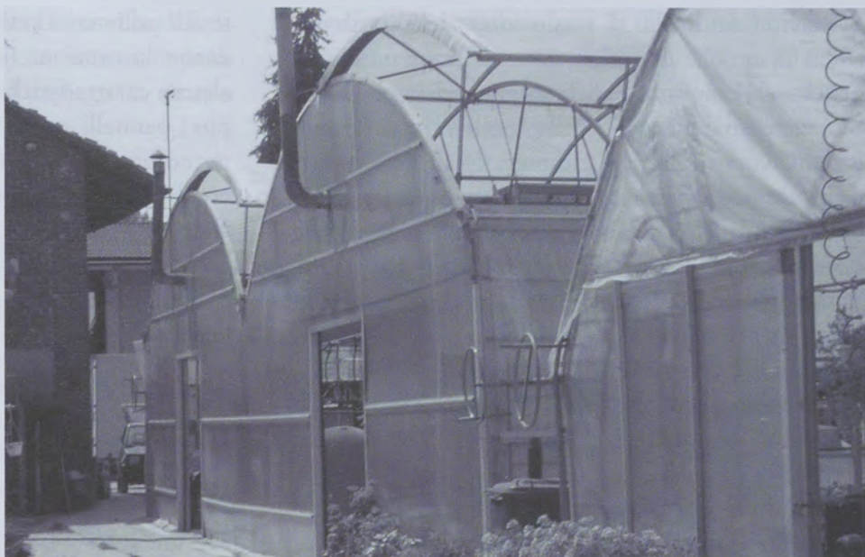
Figure 7, 8. Serre con rivestimento in film plastico.
