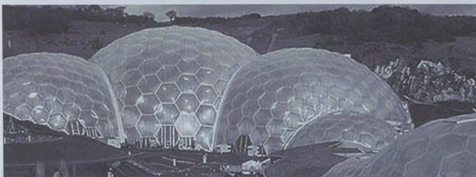
Figure 3, 4, 5, 6. Esempi di utilizzo delle materie plastiche nel settore delle costruzioni (Rivestimento di facciata in PMMA traslucido, sede Ilti luce, Torino, studio UDA; Casa provvisoria in pc alveolare traslucido, Cliostraat, Tokyo; Rivestimento di facciata in pc alveolare, Milano; Cupole geodetiche in membrane in ETFE in strati multipli; The Eden Project, N. Grimshaw, 2001, Cornovaglia, UK).
