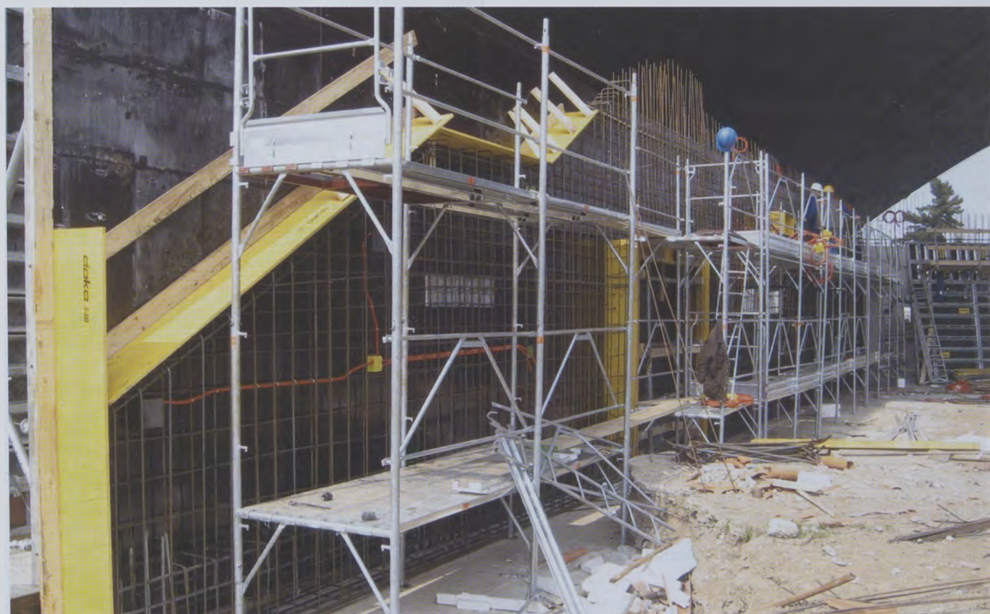
Figura 6. Gli impianti annegati nei setti.
