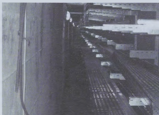
Canaline all'interno del cunicolo perimetrale esterno.
