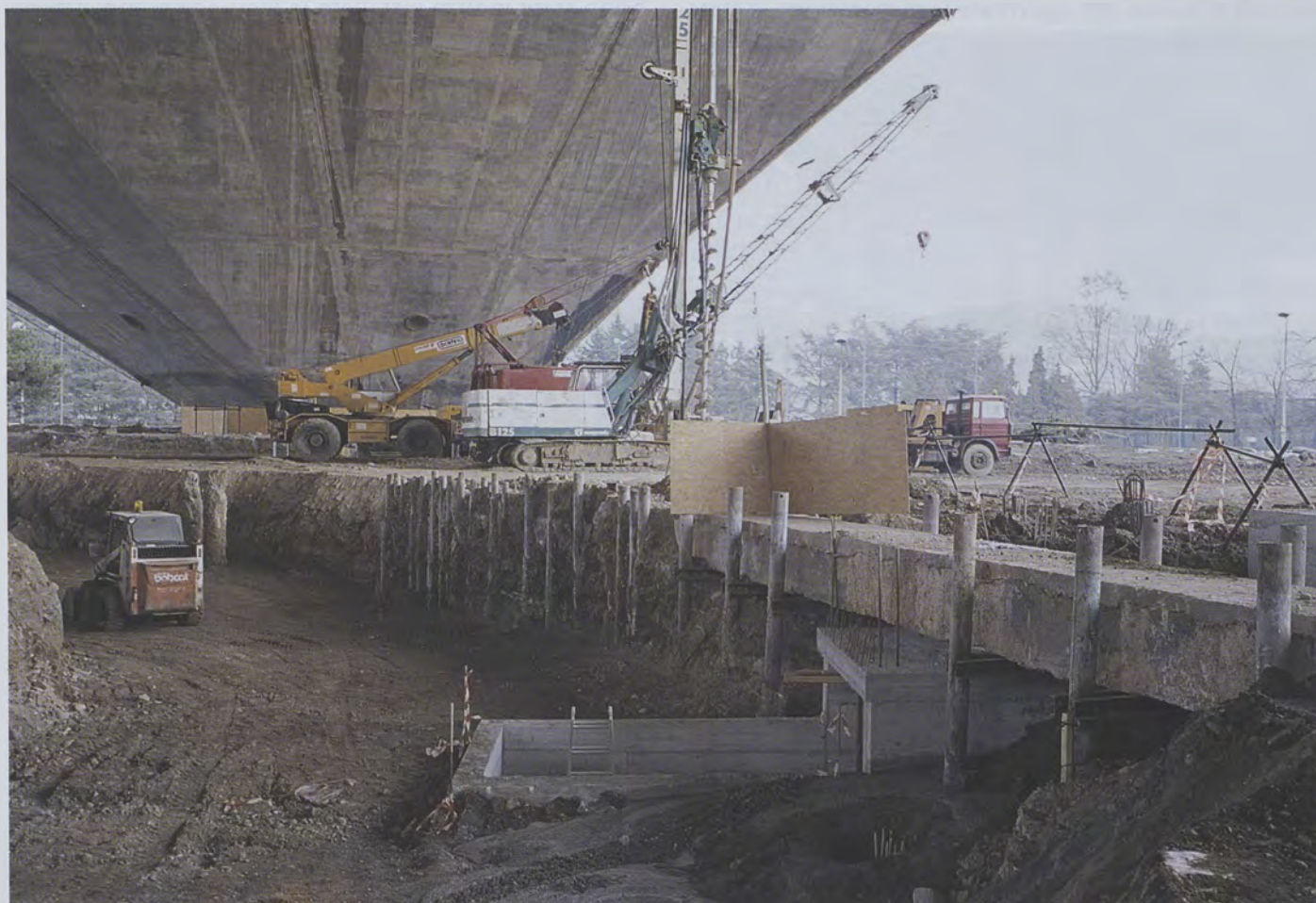
Figura 3. Il pre-scavo per i pali di fondazione. Figura 4. Il tunnel impianti al disotto dei tiranti.
