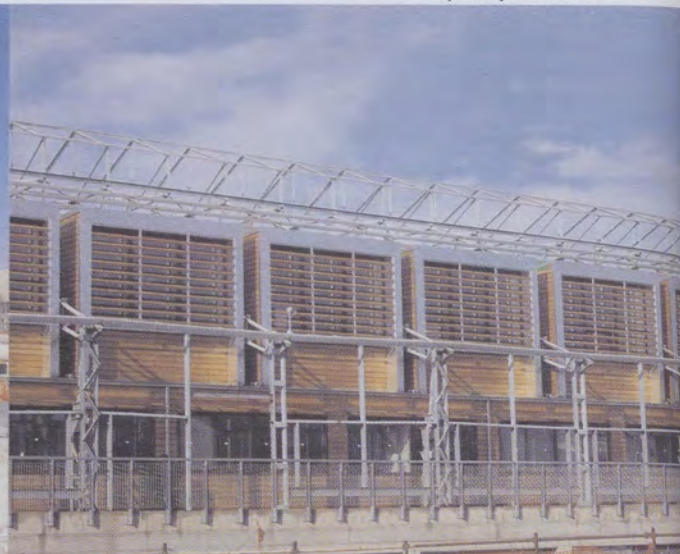
prospetto est particolare frangisole
