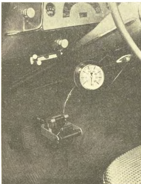
Fig. 3 - Dispositivo registratore della forza esercitata sul pedale di freno, nonché dei tempi e spazi di frenatura.
