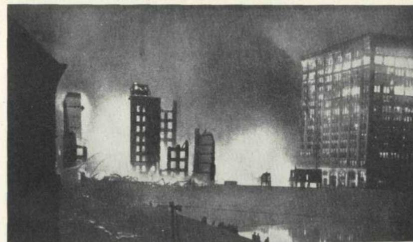
Fig. 1. - Chicago 15 marzo 1922 (edificio Burlington) - Tipico esempio di incendio propagatosi per irraggiamento. Qui per quanto la distanza della casa in fiamme fosse ben maggiore di quella che abbiamo indicato come distanza di sicurezza poichè essa era di 25 metri, il calore infranse i vetri dei piani superiori e di lì il fuoco divampò nell'interno causando danni ingentissimi.
