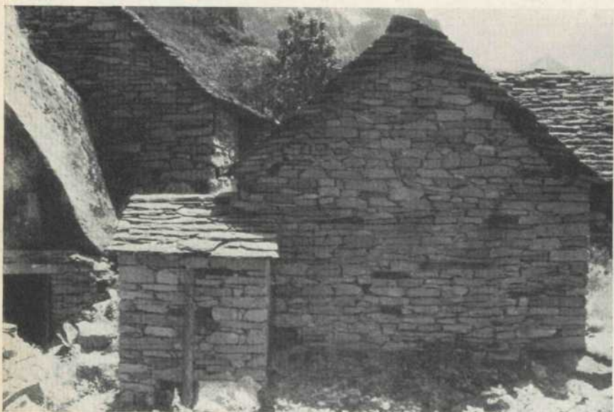
Fig. 2. - Costruzioni tutta pietra nella Valle di Brione (Verzasca, Cantoni Ticino).
