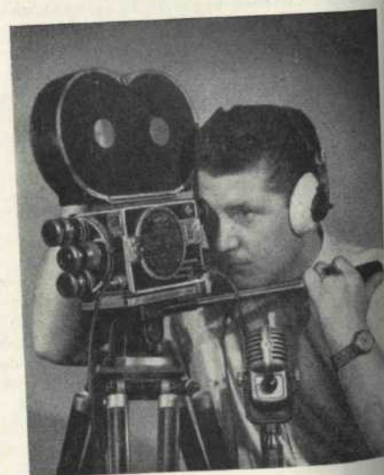
Fig. 2. - Ripresa del quadro e suono con pellicole separate.
