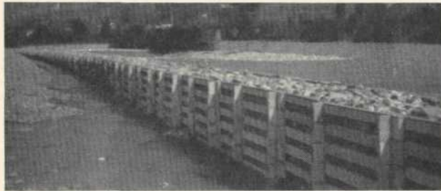
Fig. 4. - Sistemazione Dora Baltea in Comune di Aosta.
