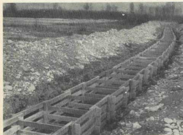
Fili. 5. - Difesa in sponda sinistra Dora Baltea in Comune di Aosta.
