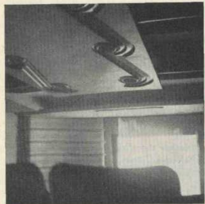
Fig. 1b - Exemple d'une salle ne présentant pas de reflets parasites, mais où la vision est gênée par les lampes de signalisation de l'éclairage de sécurité. (photo J. Vivie)
