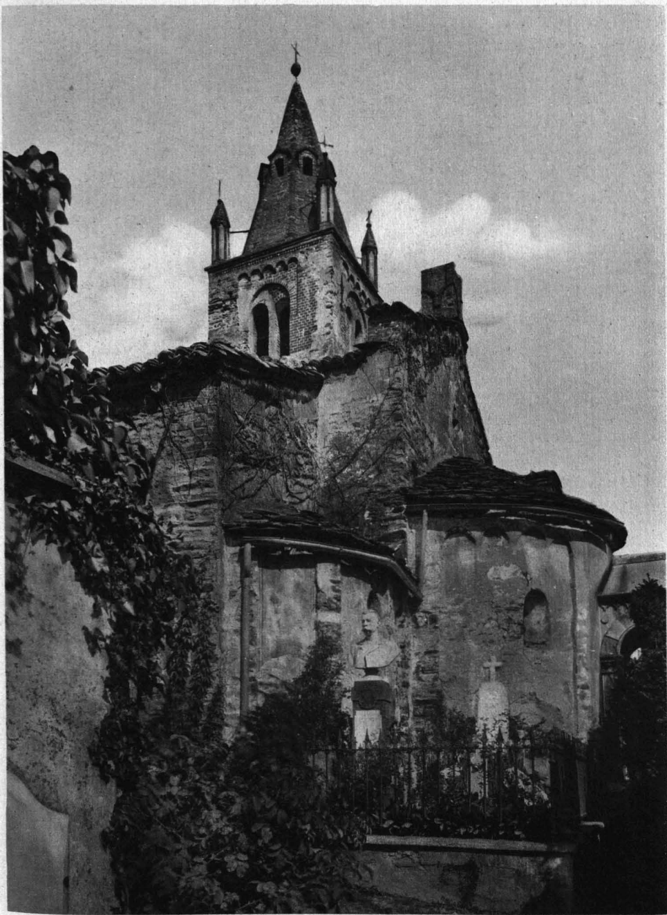
Avigliana - San Pietro al Cimitero. Absidi e campanile.
