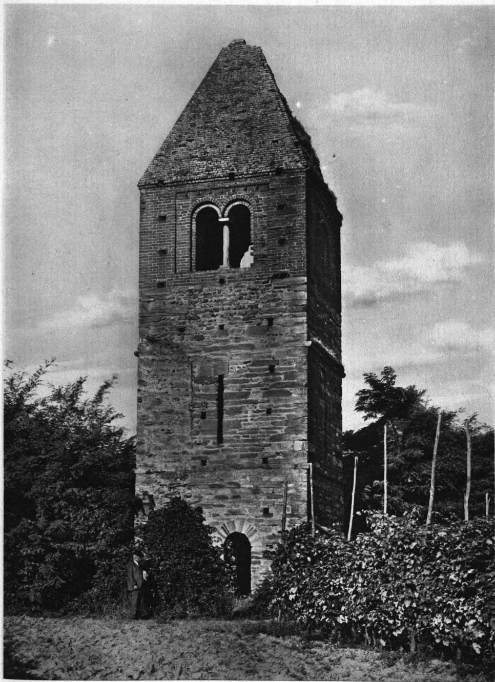
Rivoli - Il campanile di S. Martino dei Campi. Lato sud-est.
