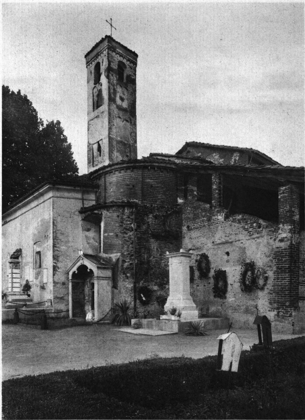
San Maurizio Canavese - Chiesa del cimitero. Abside e campanile.
