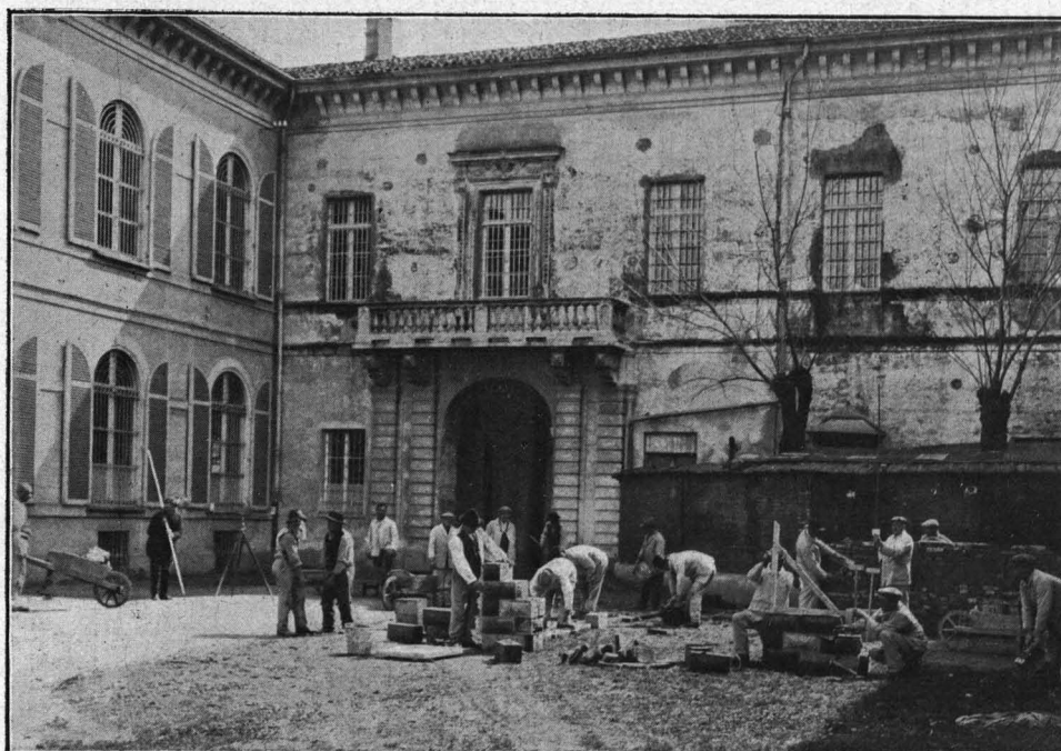
Collegno - I muratori iniziano un garage.
