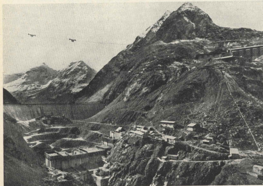
Fig. 2 - Grande Dixence: la diga preesistente, la nuova diga in costruzione e le attrezzature di cantiere (Soc. An. Grande Dixence).
