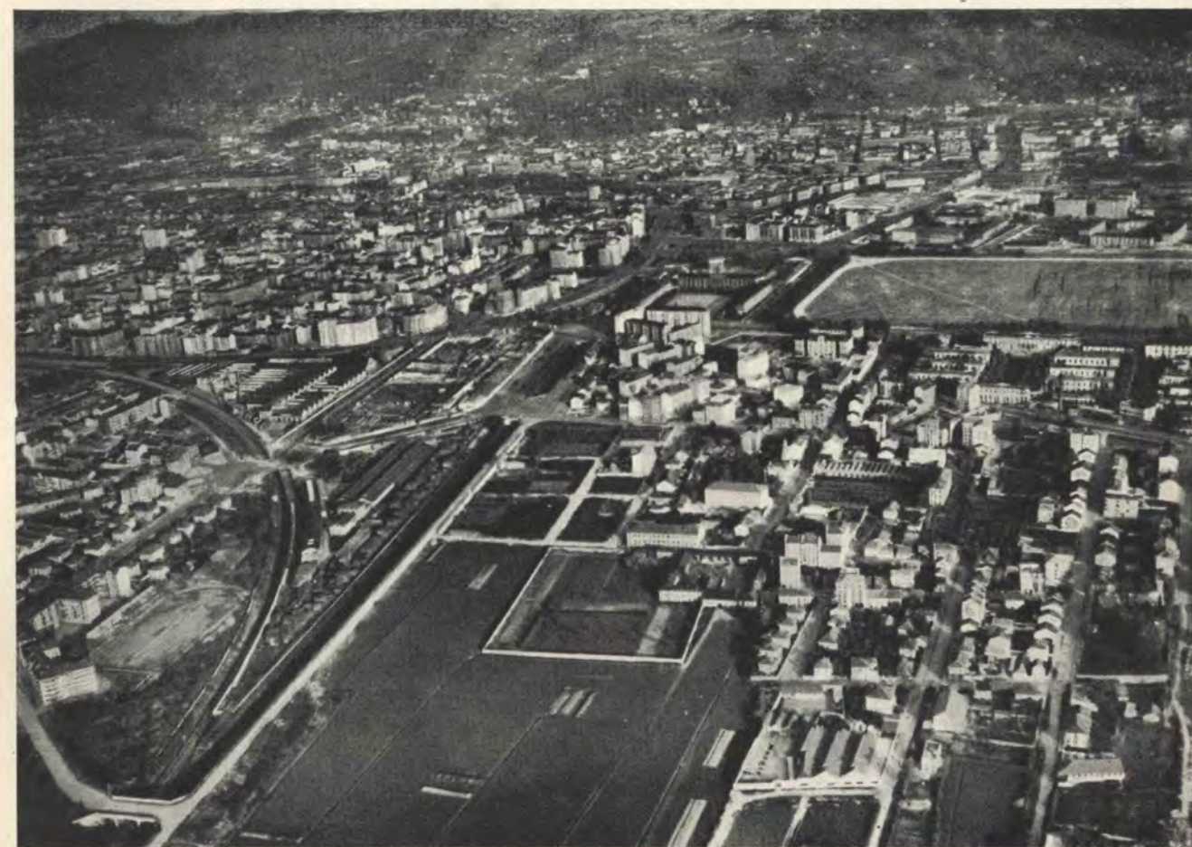
Fig. 7 - Effetti dell'espansione malamente disciplinata di Torino oltre la cintura ferroviaria.
