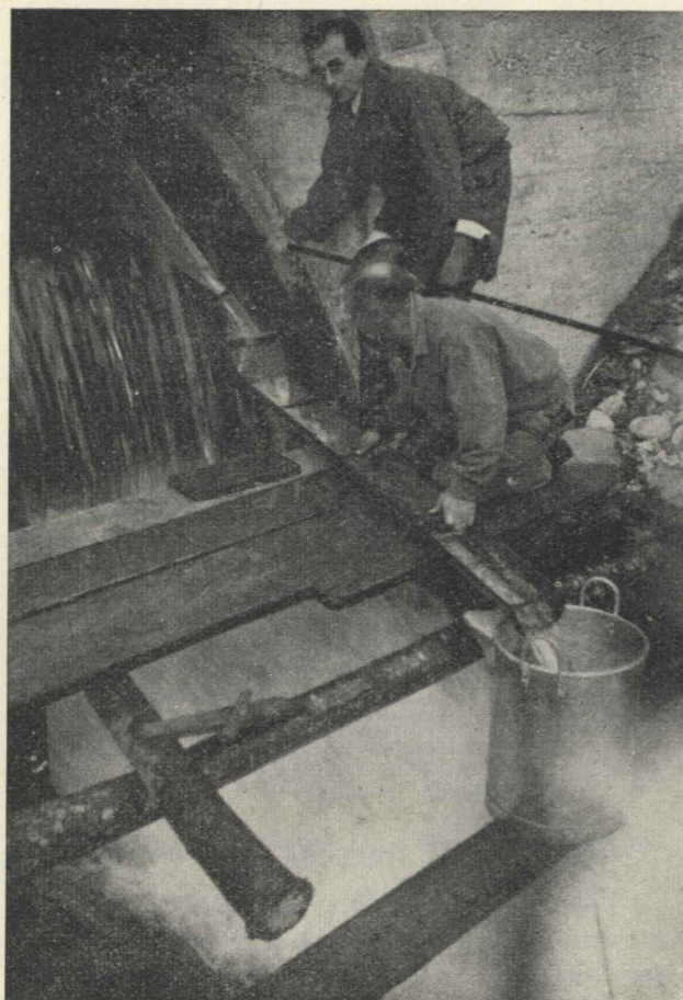
Fig. 4 - Taratura del prelevatore a fessura sullo stramazzo Bazin allo scarico della Centrale di Olivioni.
