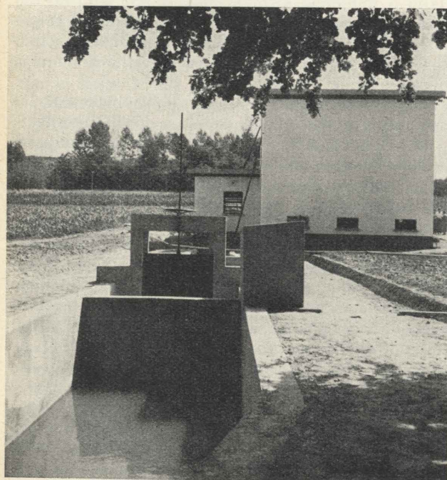
Fig. 2 - Opere di presa, misura e decantazione delle acque.
