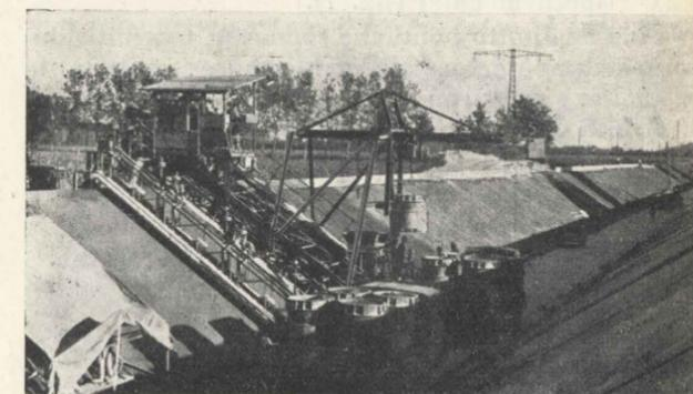
Fig. 3 - Vibrofinitrice «Dingler» in funzione.
