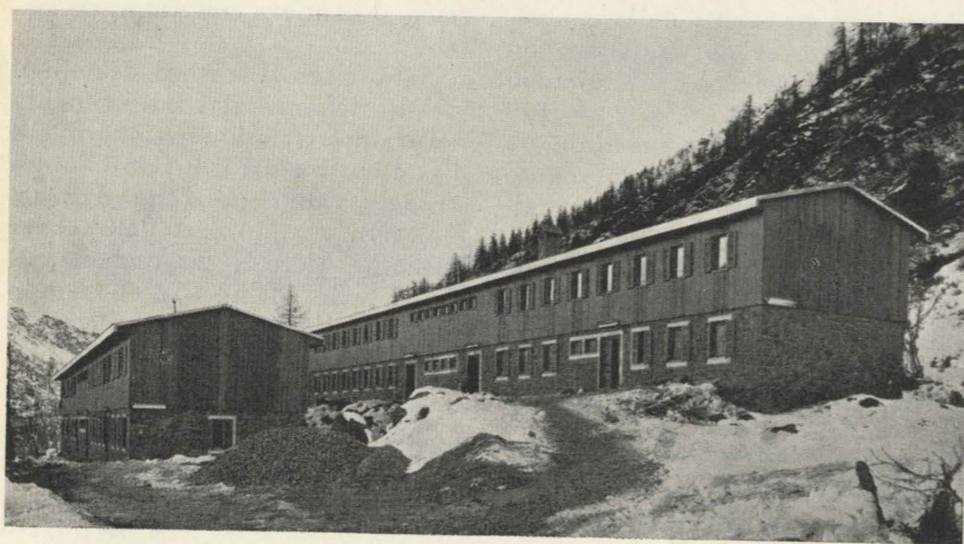
Fig. 7 - Edifici per alloggiamenti ed uffici impresa.
