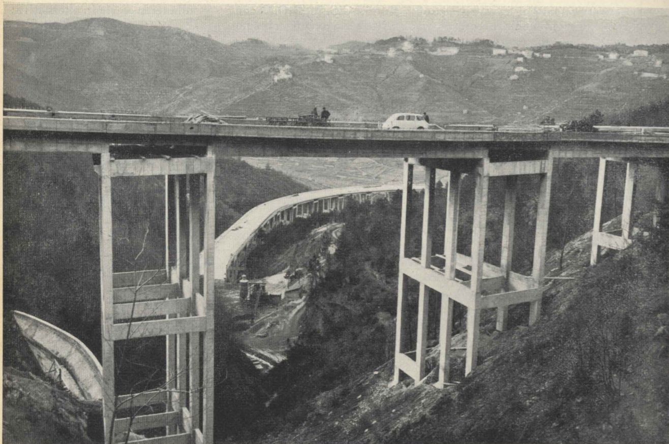
Fig. 16 - Viadotti Gogole e Gaggie. LOTTO IV - Impresa Recchi.
