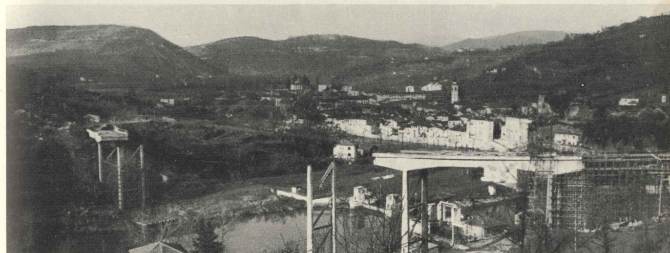
Fig. 26 - Viadotto Bormida di Millesimo, LOTTO VIII - Impresa S.I.G.I.C.
