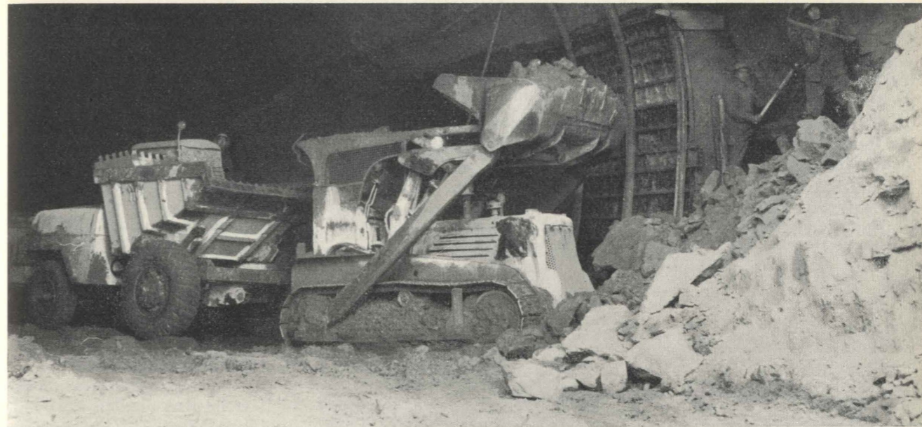
Fig. 35 - Galleria Pione - Sottomurazione piedritti. LOTTO X - Impresa SACOP.
