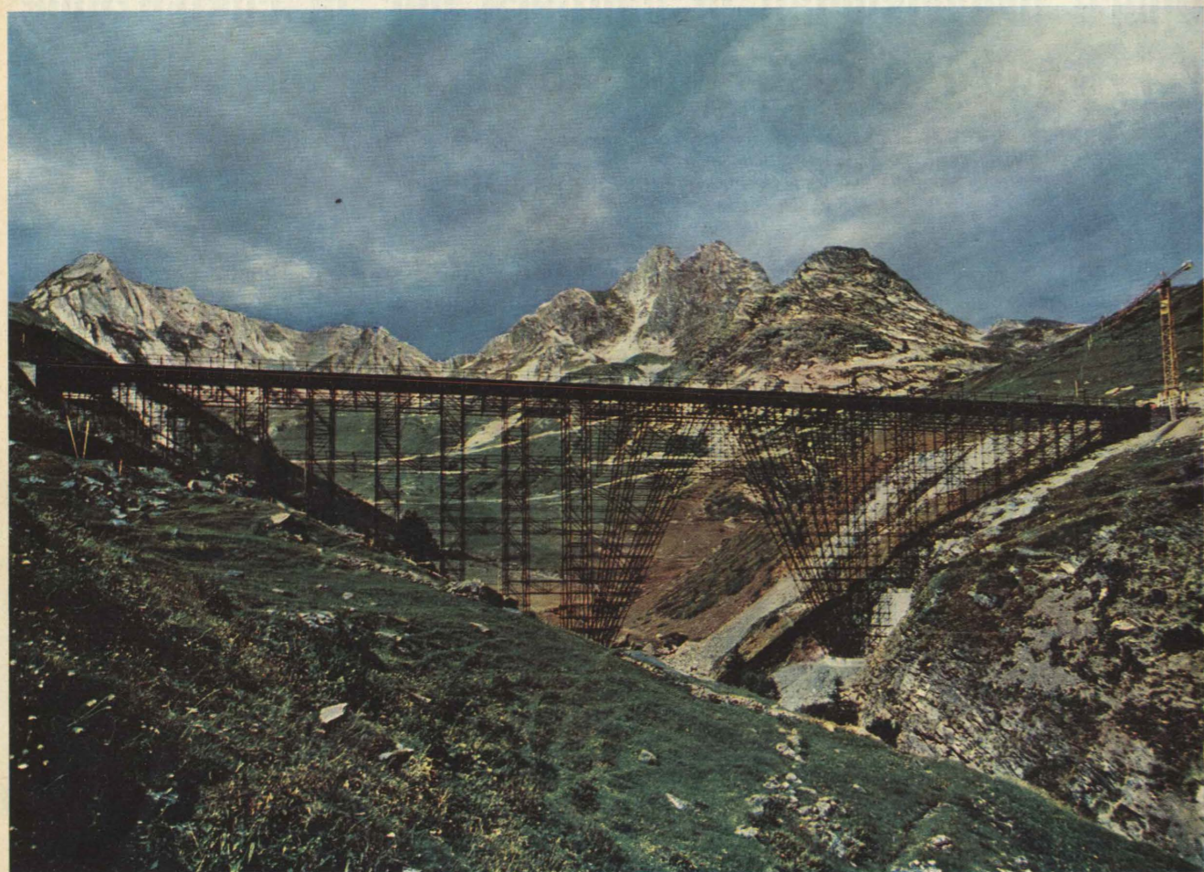
Fig. 2 - Vista generale da valle del viadotto provvisorio.
