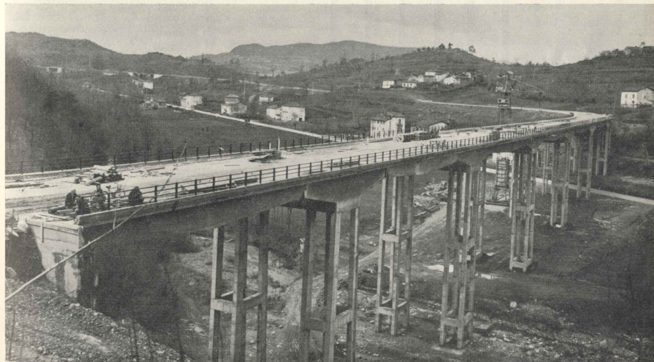
Fig. 23 - Viadotto Nanta - Vista dall'alto.
