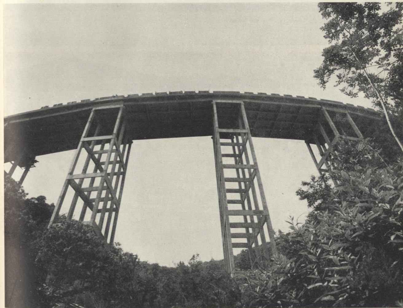
Fig. 15 - Viadotto Teccio. LOTTO IV - Impresa Recchi.
