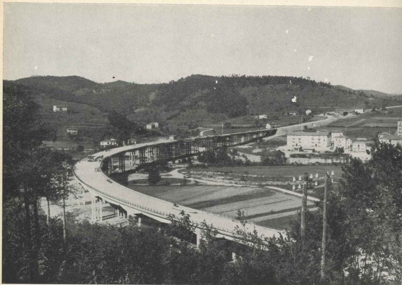
Fig. 20 - Viadotto Bormida di Pallare. LOTTO VII - Impresa Sogene.
