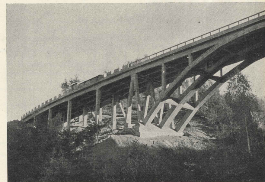
Fig. 30 - Viadotto Batei. LOTTO IX - Impresa Norzi.
