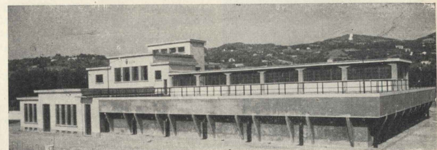
Impianto di riserva per trattamento dell'acqua del Po.
