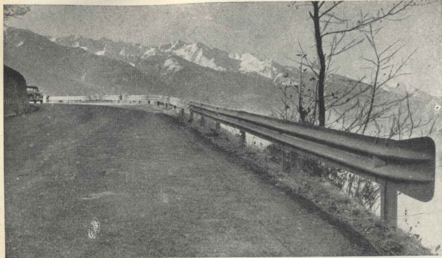
Fig. 6 - Sostegni applicati su muro di tenuta.
