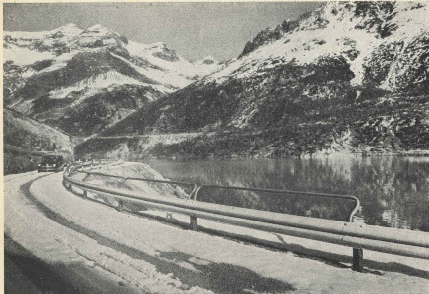
Fig. 13 - Facile sgombro della neve ottenuto con le barriere di acciaio.
