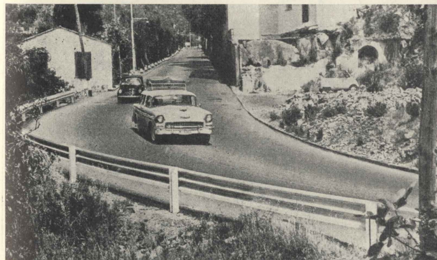
Fig. 12 - La stessa curva dove, al muretto, è stata sostituita la barriera di acciaio.
