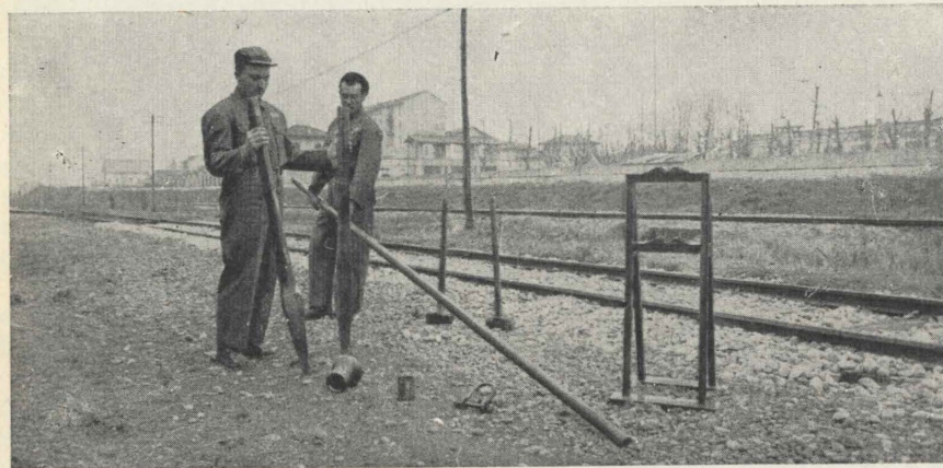
Fig. 7 - Parti componenti l'attrezzatura per perforare il terreno.
