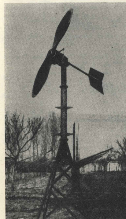
Fig. 24 - Impianto aereoeltrico di piccola potenzialità.
