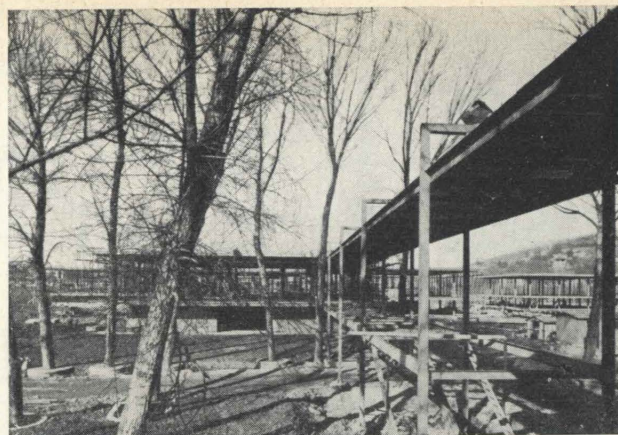
Ultimazione delle coperture dei padiglioni e passerelle.
