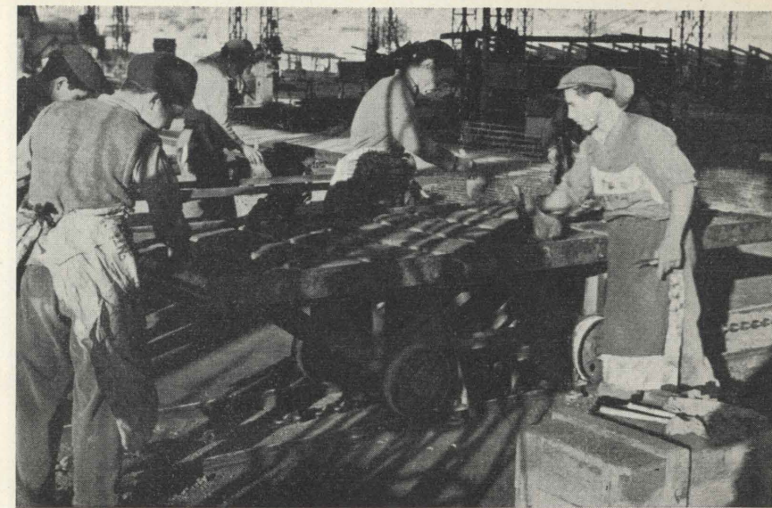
Fig. 20 - Pulizia della forma con aria compressa e spazzole.
