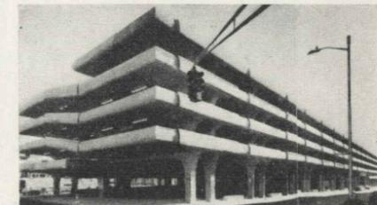
Autoparcheggio in cemento armato del tipo a rampe capace di 1.500 autovetture a New Haven (Stati Uniti).
