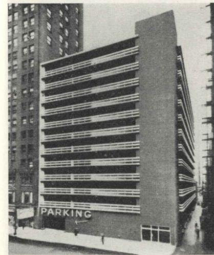
Autoparcheggio in struttura metallica del tipo a montacarichi capace di 495 autovetture a Chicago.
