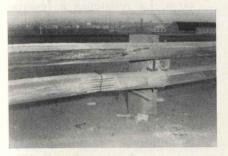
Fig. 11 - Rottura tipica del nastro inferiore della barriera.
