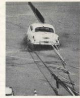
Fig. 6 - Prova di un veicolo contro barriera a cavi (HRB Bollettino n. 266).
