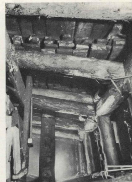
Fig. 8 - Cunicolo di avanzamento in calotta in corrispondenza di un rilascio a progr. 500 (Monte Bianco).
