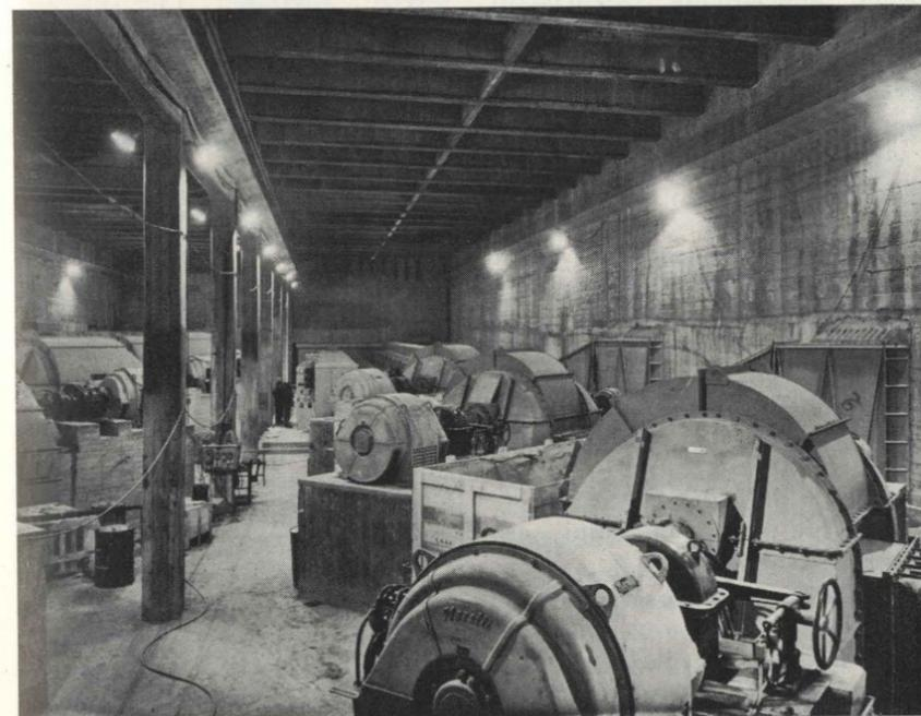
Fig. 19 - Monte Bianco. Centrale sotterranea di ventilazione lato Italia.
