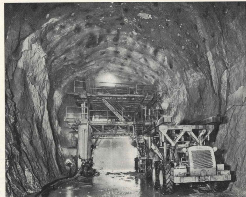
Fig. 7 - Jumbo per avanzamento in piena sezione. E visibile la nebbia d'aria e d'acqua in pressione proveniente dalle 18 perforatrici in azione.
