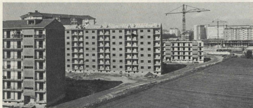
Fig. 7 - Gli edifici di via Pergolesi quattro mesi dopo l'inizio dei lavori.
