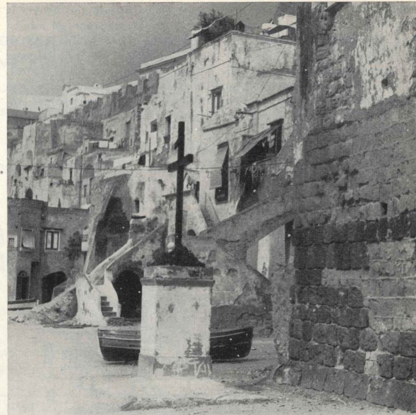
Fig. 5 - La Corricella, il baricentro dello spazio collettivo.
