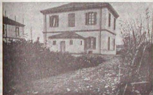
Fig. 7. — Fronte posteriore di una casa del villaggio Crespi.
