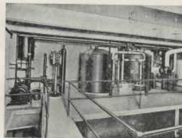
Impianto funzionante presso la Piazza della "Casa dei Balilla", di Torino
