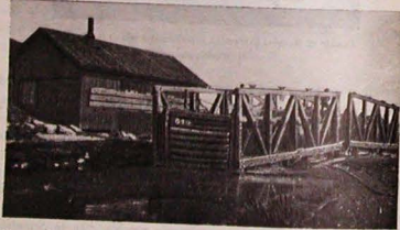
Canale di Morris. Estremità superiore del piano inclinato di Washington.
