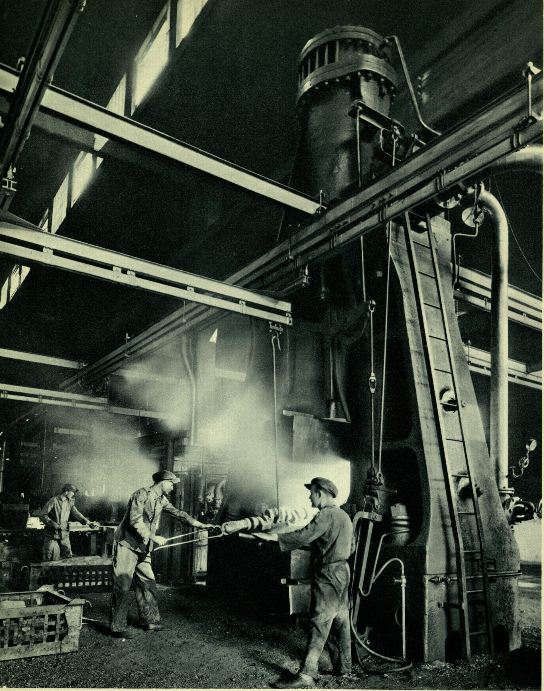
Grande meglio ad aria compressa di 12.000 kg.
