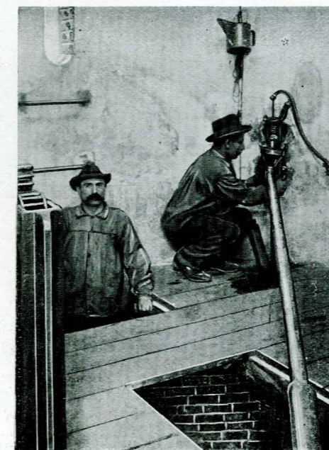
Lavoro in un pozzo laterale di un gasometro.
