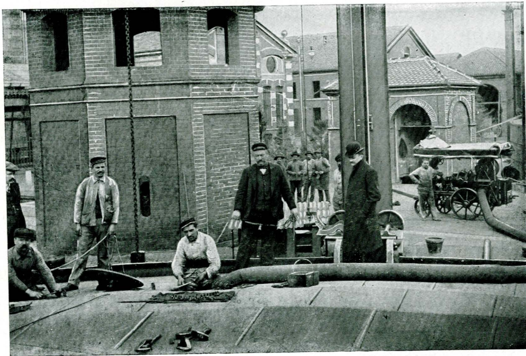
Ventilazione artificiale durante la riparazione d'una campana di un gasometro.
