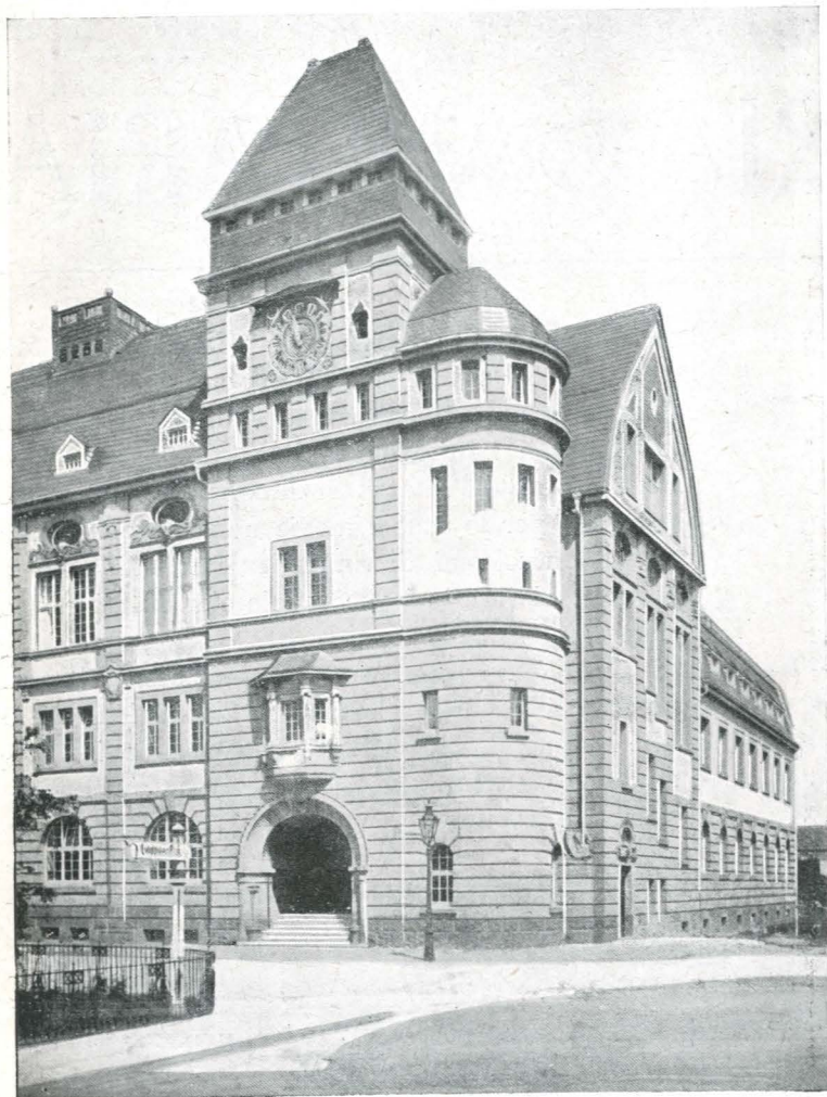
Particolare architettonico della facciata con l'ingresso allievi
