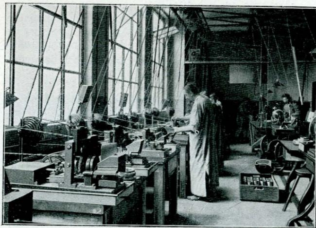
Fig. 8. - Fabbricazione automatica delle ruote dentate.
