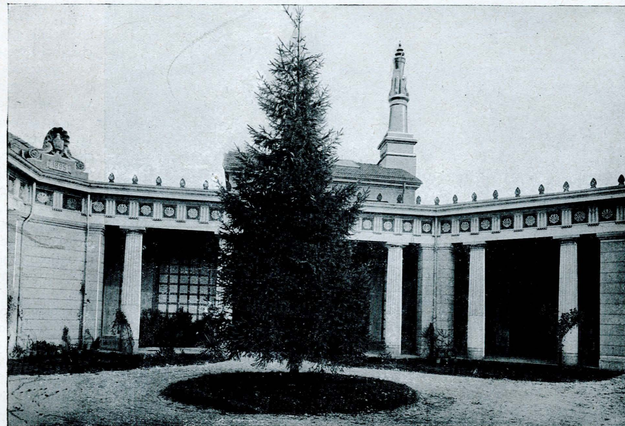
Crematorio di Torino - Ingresso dalla via di Circonvallazione.
