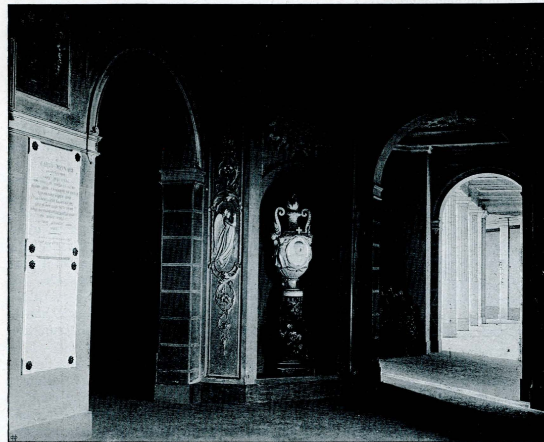
Crematorio di Torino - Atrio d'ingresso dalla parte del Cimitero Generale.
