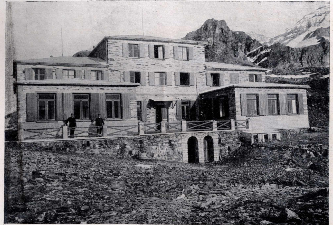
Fig. 8. — Istituto Angelo Mosso, veduto di fronte, con in fondo lo Stohlenberg.
