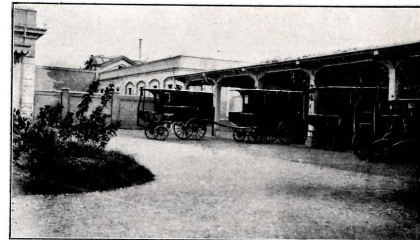
Fig. 11. - Tettoia dei veicoli e per la preparazione dei disinfettanti.
