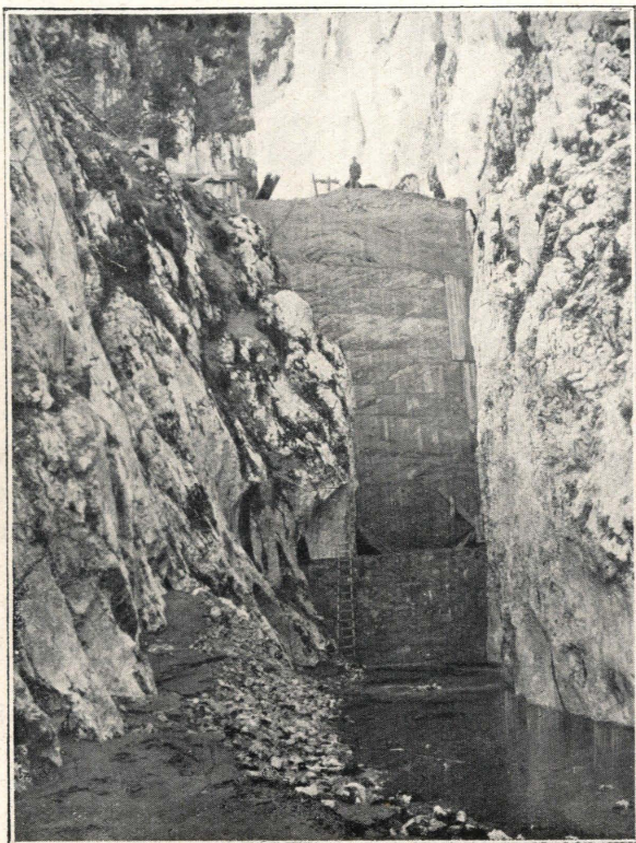
Fig. 7. - La diga disarmata, vista da monte.
