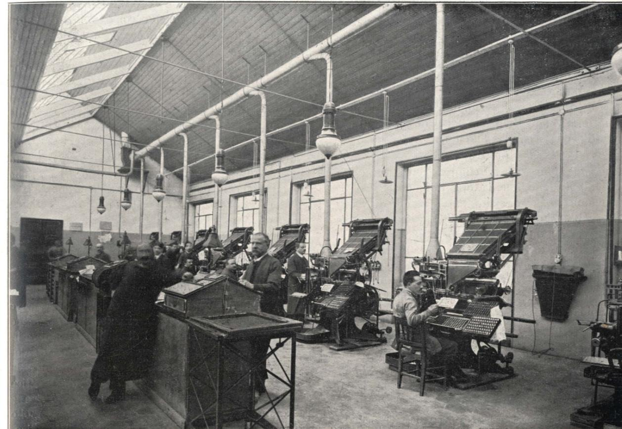
Fig. 8. - Impianto di aspirazione dei gas e vapori sviluppatissimi dalle Linotypes, presso il giornale *Il Secolo* di Milano.
