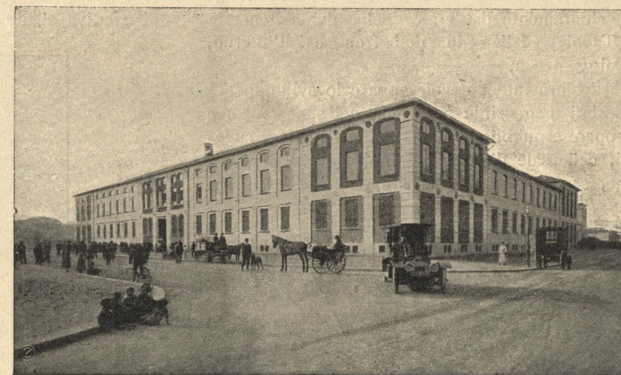
Fig. 1. - Veduta generale esternadello Stabilimento Antonio Vallardi. Milano, Via Stelvio, 2, angolo Via Lario.
