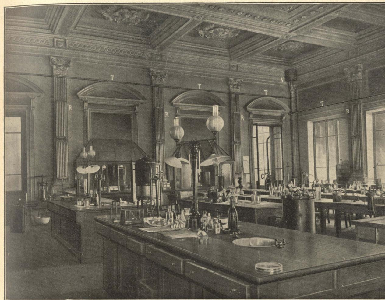
Fig. 3. — Interno della grande sala di laboratorio dell'Istituto di Igiene con distribuzione dei radiatori murali.
