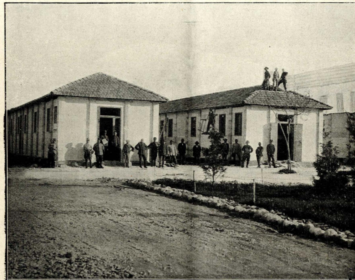
Fig. 3. — Veduta di fianco e di testata di due padiglioni dell'ospedale militare di 1000 letti in Udine in c. «Selenit».
