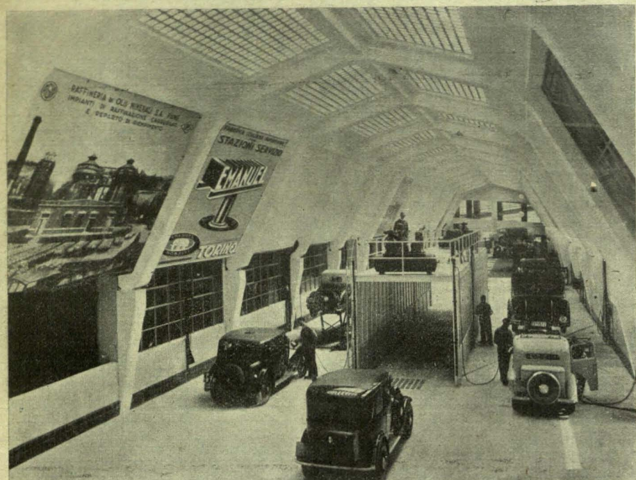
AUTORIMESSA AGIP VENEZIA Posto di lavaggio con sollevatori a parallelogramma (Apparecchi Emanuel, Torino)
