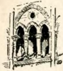
à contrebuter la poussée du berceau central. Quelquefois le triforium s'ouvre directement sous le comble des collatéraux; enfin, comme à la cathédrale d'Amiens, on trouve un triforium séparé du comble en appentis, par une cloison fixe.
