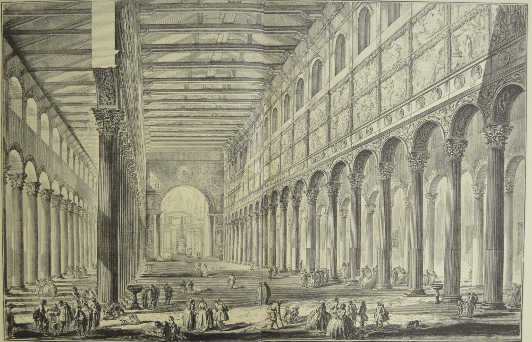
Spaccato interno della Basilica di S. Paolo fuori delle Mura, eretta da Costantino Imperatore, presentando le Navate spaziate di grandezza e larghezza le laterali da quelle della Piazza, e nel mezzo. Altre Colonne, dieci di Grado sono sparse per la Chiesa, in forma alla quale, come questa interna di Basilica di mezzo. Il Pavimento delle Navate è ornato di colli pezzi di marmo, tirati dalla rovina di altre Edifici antichi. P. Piranesi del. G. B. Piranesi sculp.
