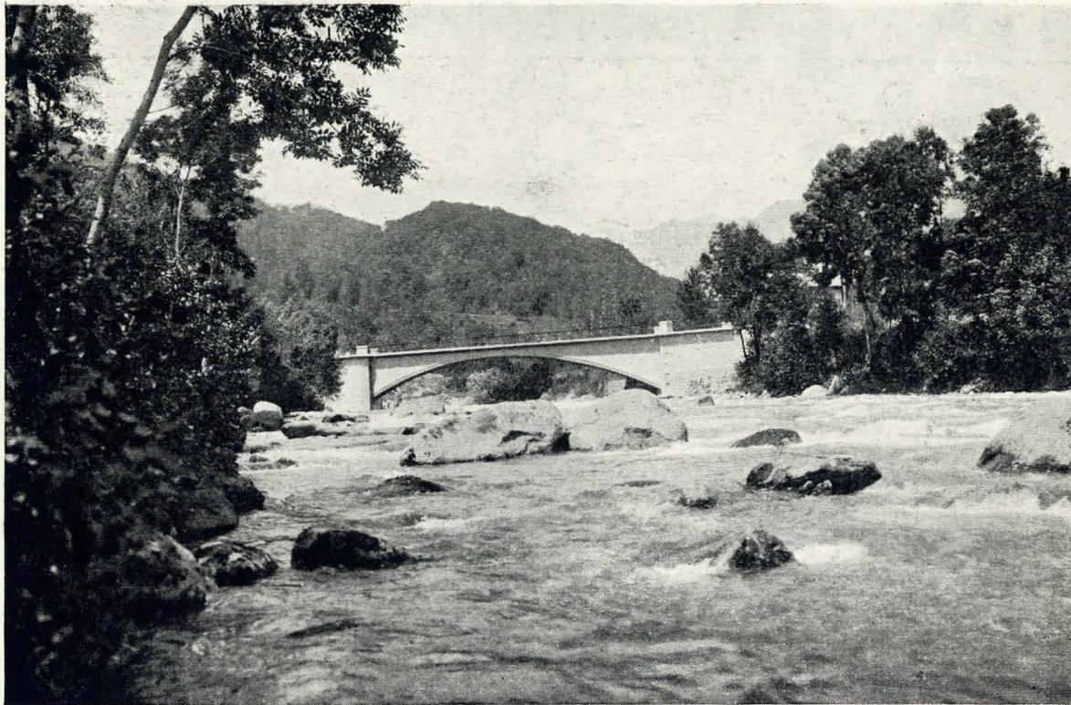
Ponte di m. 40 di luce e 3,90 di freccia.
