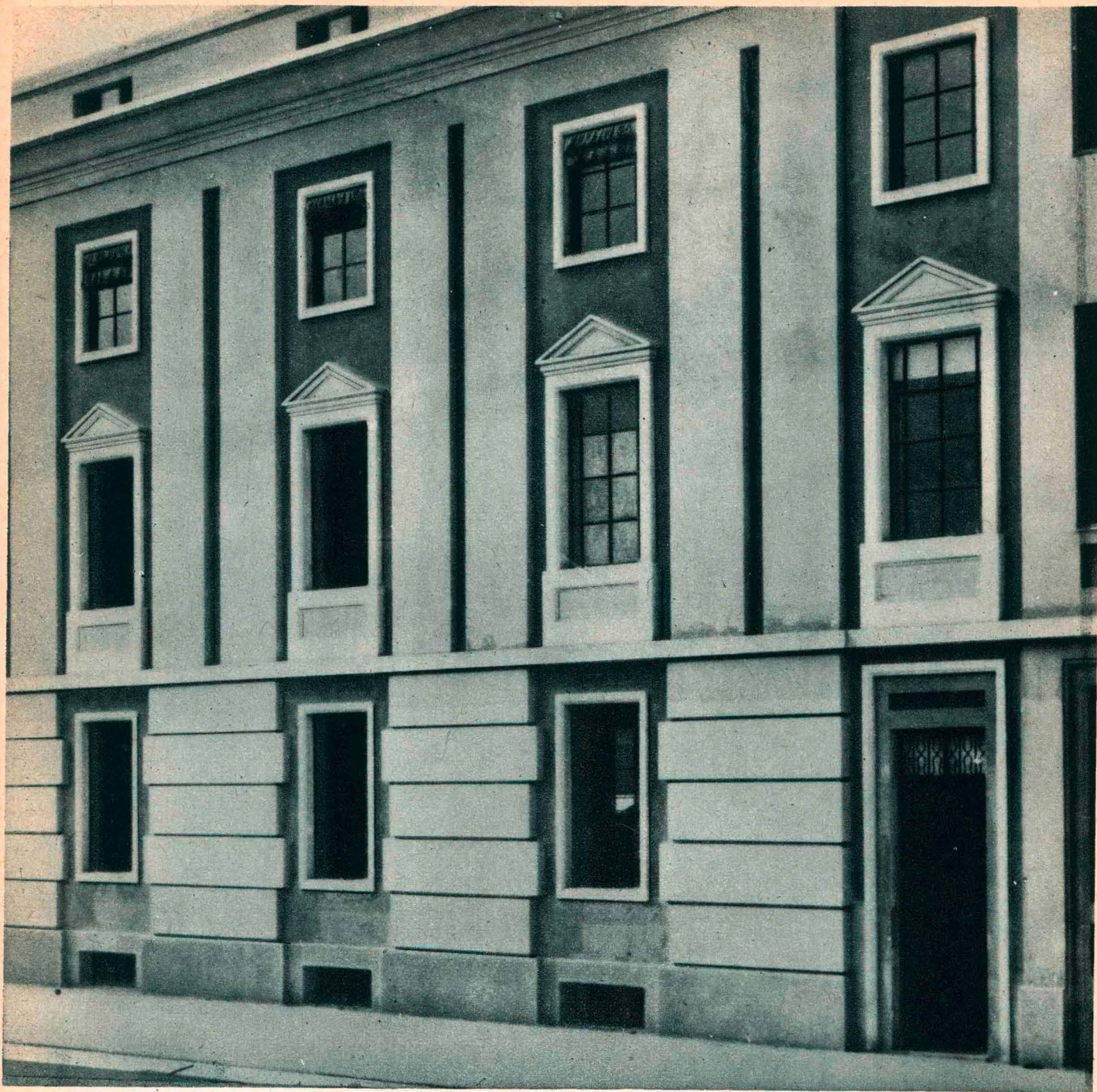
EDIFICIO PER I SERVIZI NELLO STABILIMENTO C. ERBA IN MILANO (PARTICOLARE)
