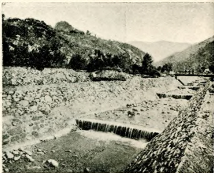
Fig. 34. — Bassa Gryonne nelle vicinanze del vecchio ponte di Salaz
